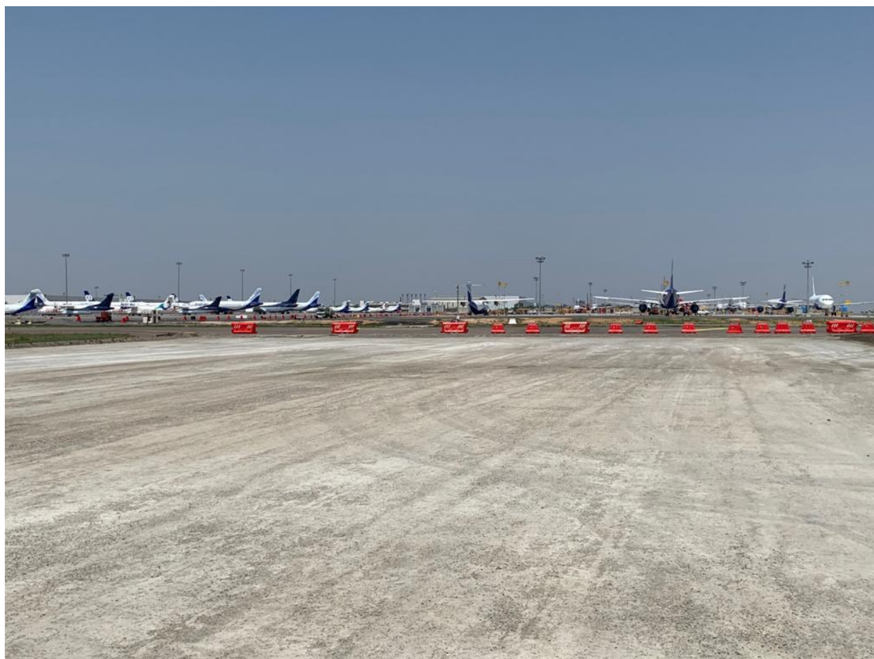
Стабилизированный грунт
