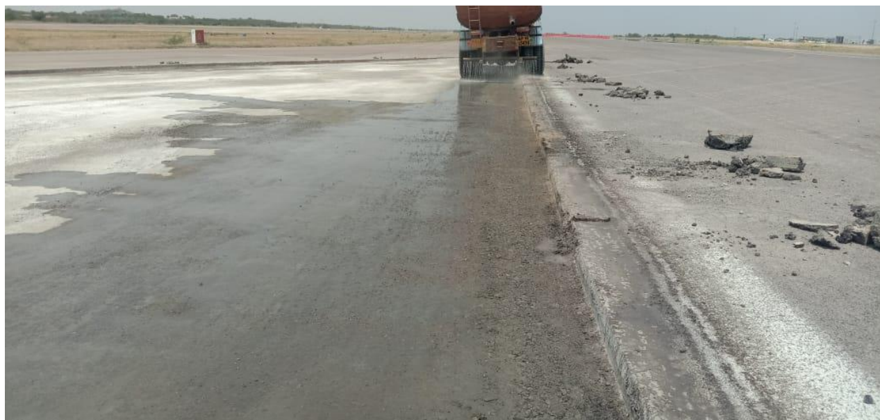
Стабилизированный грунт
